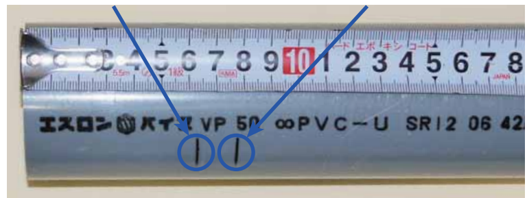
継手差込マークライン（施工用）
