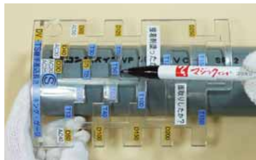
継手差込マークライン（施工用）
